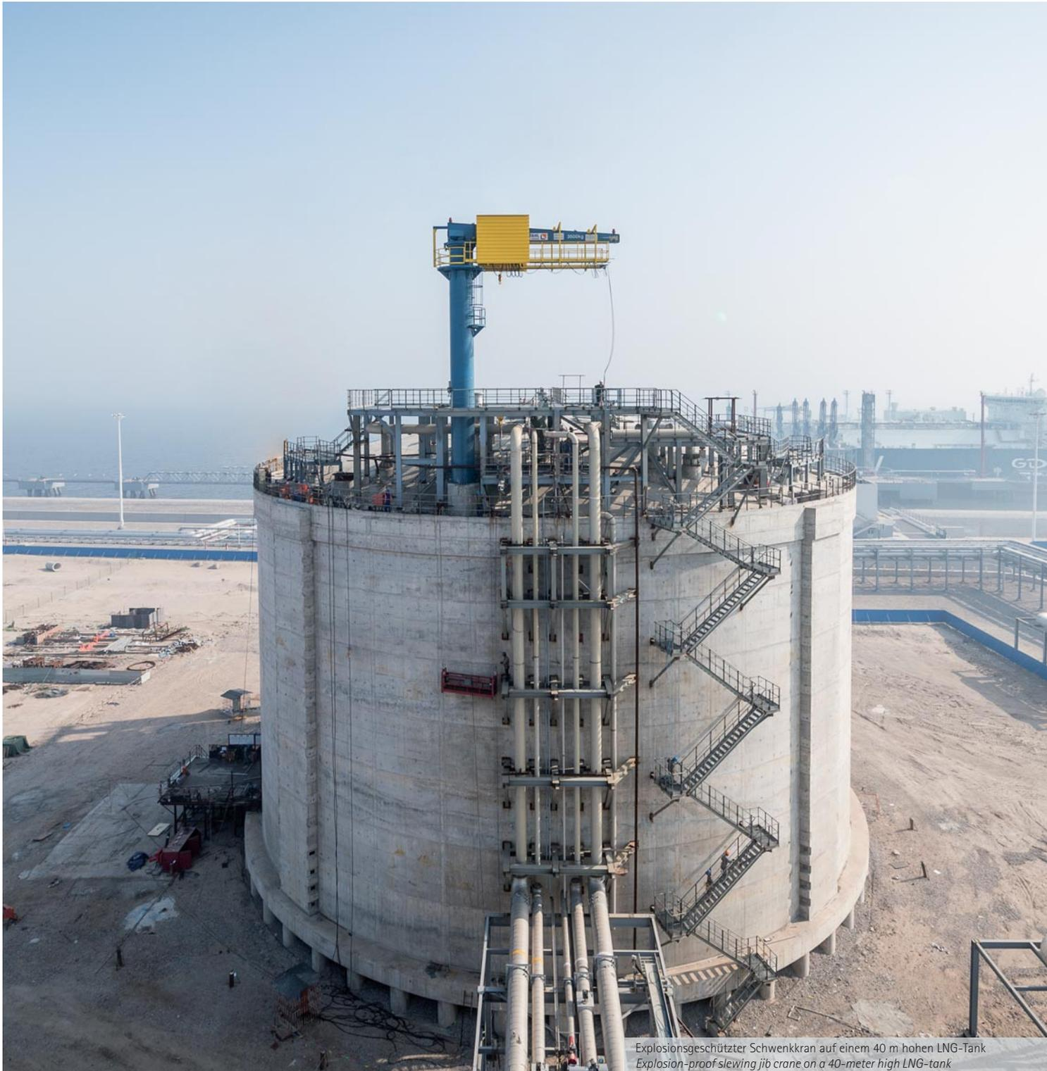
Explosionsgeschützter Schwenkkran auf einem 40 m hohen LNG-Tank
