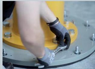
**Schnelle und einfache Ausrichtung** der Verbund-Anker-Platte durch integrierte Ausrichterschrauben.
